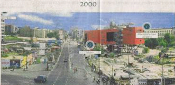
Im Wandel: Die Aufnahme von Jacques Obers zeigt den Potsdamer Platz noch als große Baustelle.
