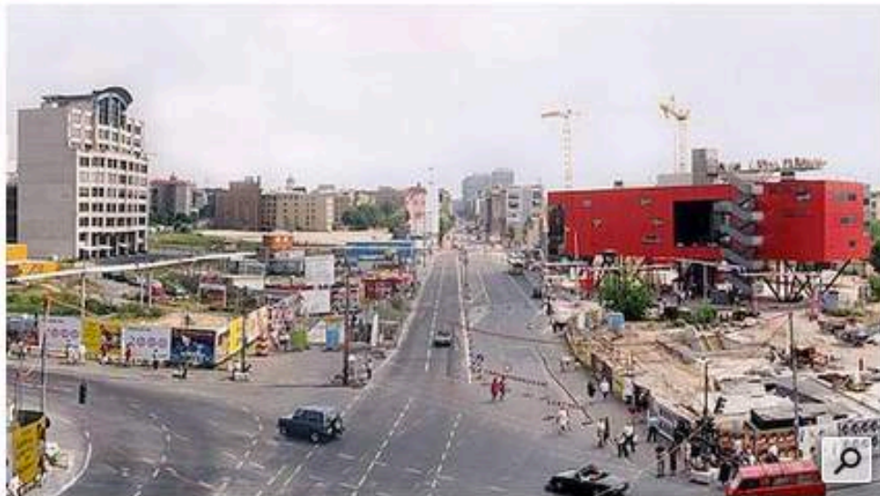
Weites Feld. Der Potsdamer Platz Ende der 1990er Jahre. Rechts die rote Info-Box, in der man sich über die Bauarbeiten schlau machen konnte. - FOTO: JACQUES OBERS
